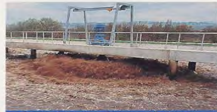
Bassin d'aération - Traitement biologique
